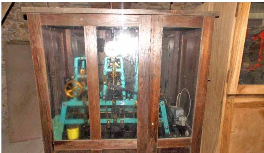
Věžní hodiny ELEKON slouží od roku 1994..
