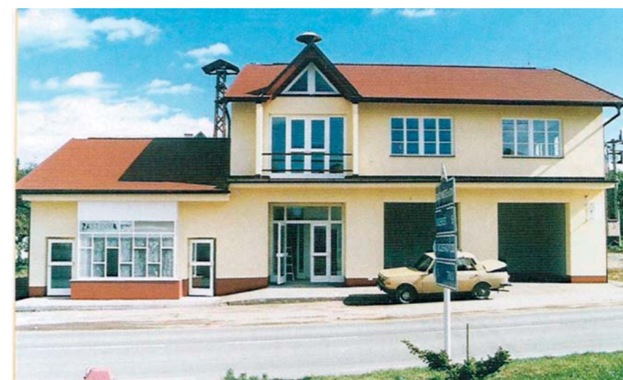
Hasičská zbrojnice po celkové přestavbě (rok 1996).
