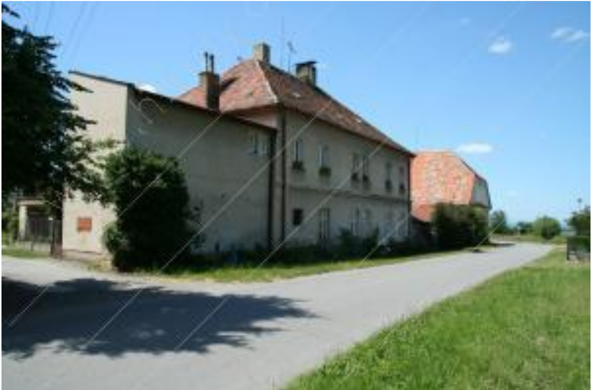
Hlavní budova Dvora podél komunikace k Mokrému
